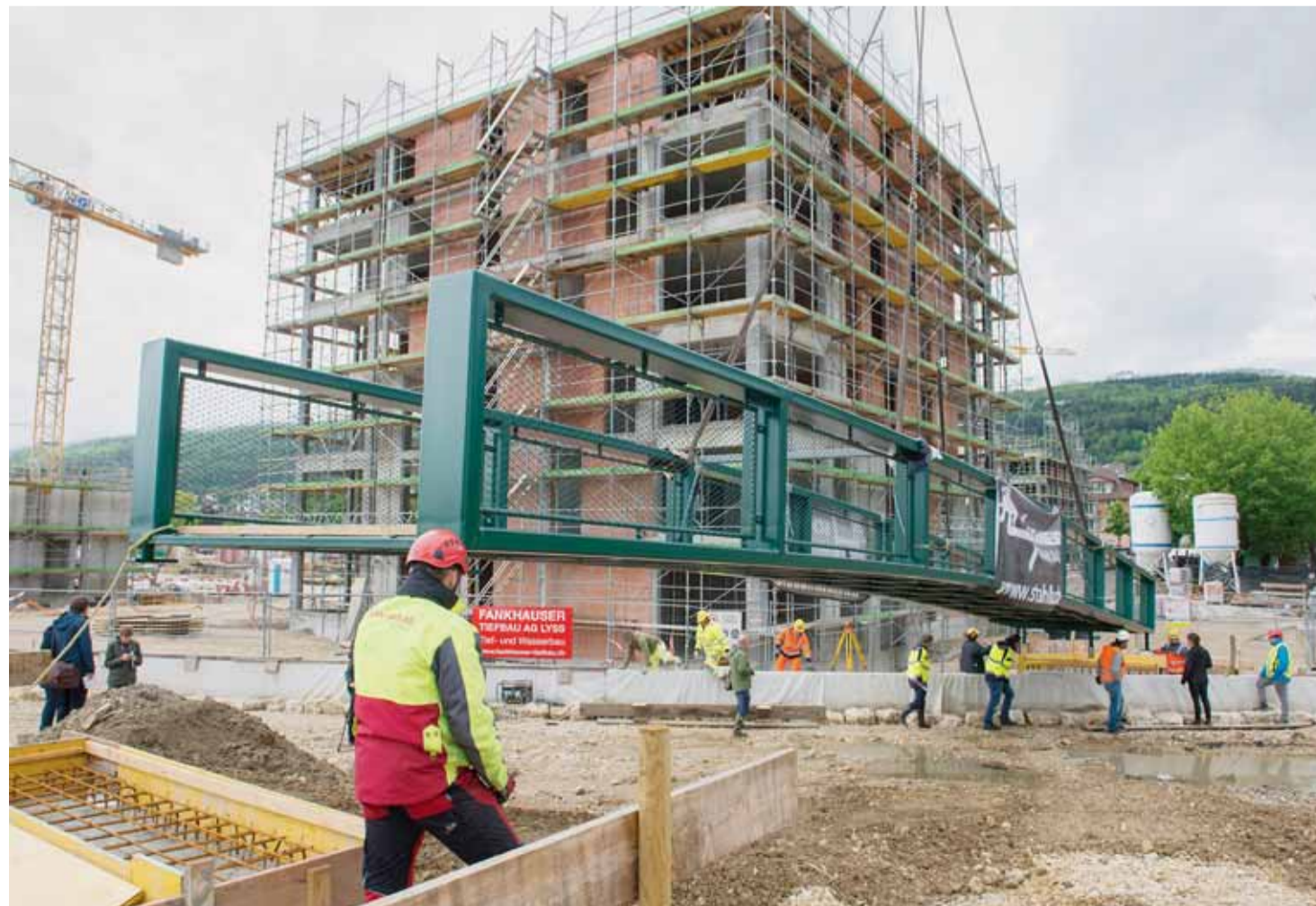
Eine der sechs Brücken zur Schüssinsel. Im Hintergrund das angrenzende neue Wohnquartier mit 280 Wohneinheiten.
