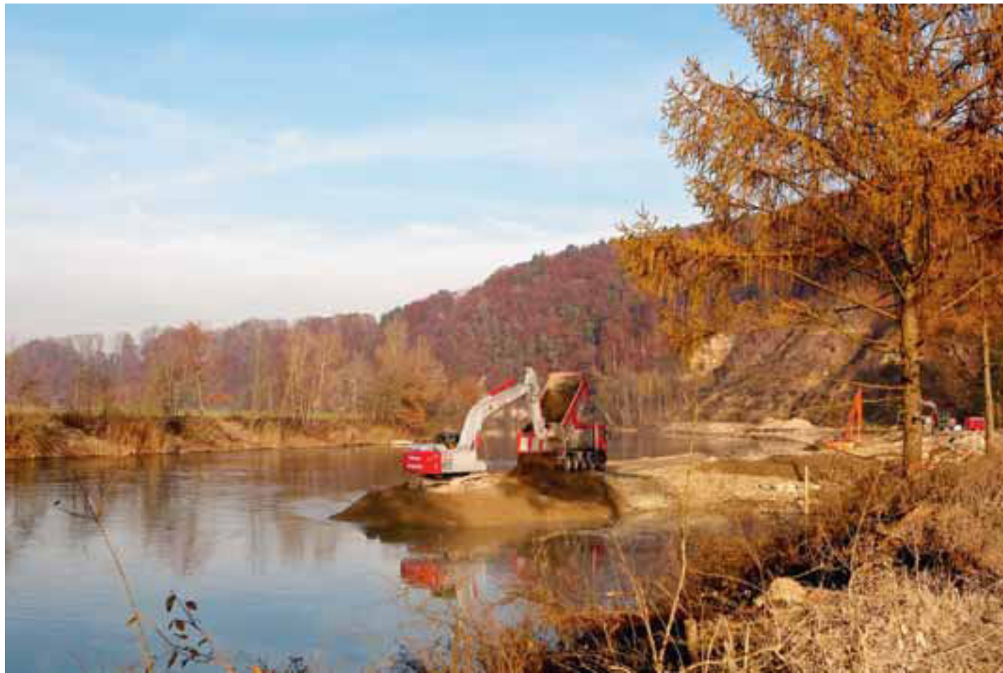
Die künstliche Insel, das Herzstück des Renaturierungsprojektes bei Niederried, hat bereits Formen angenommen.
